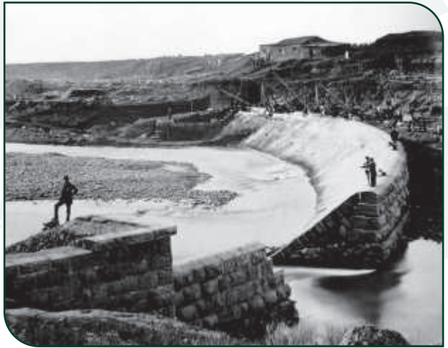
J. Laurent. Construcción de la presa del Canal del Henares (1866) ▲
